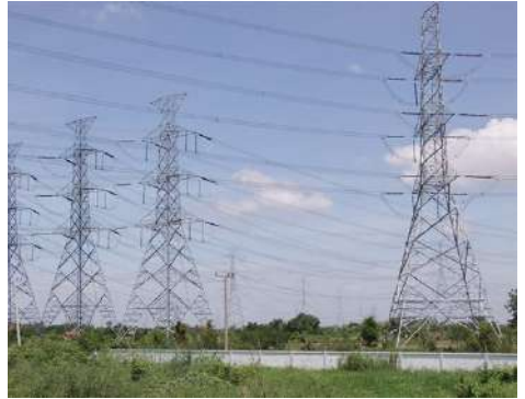
เสาไฟฟ้า
